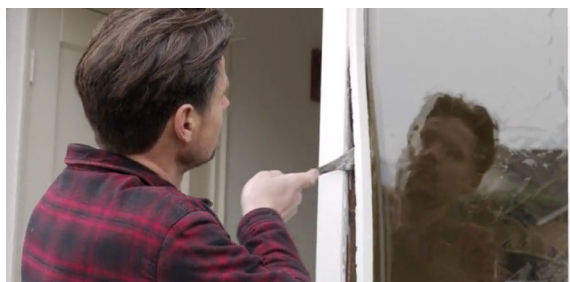
Verwijder eerst de lange glaslatten, daarna de korte
