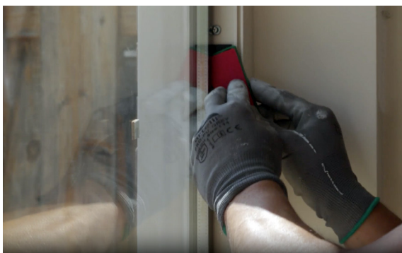
Vul de zijkanen nu uit met glasblokjes op de glasblokzadels.
