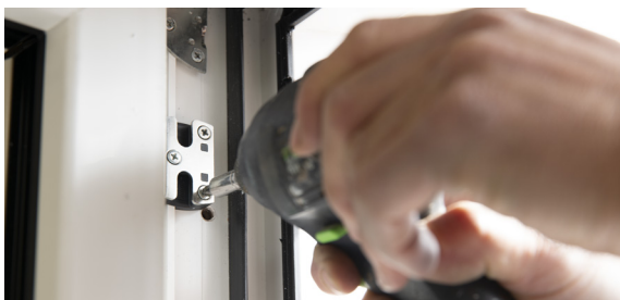
Schroef sluitblokjes die dicht op schroefgaten zitten tijdelijk los.
