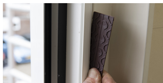
Vul eventuele ruimte bij de schroeven tussen het hout en het ClickOver kozijn op met vulplaatjes, zodat je kozijn niet kromtrekt.
