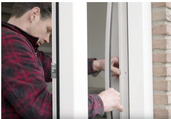
Verwijder de kunststof glaslatten van vast glas,
