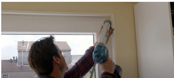
Kit de naadjes tussen de strips en je muur of aftimmering netjes af.
