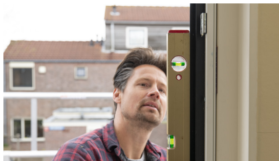
Controleer eerst of het kozijn waterpas staat
