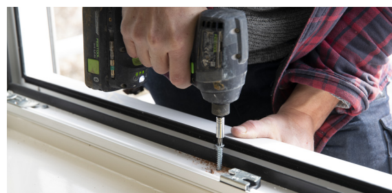
Schroef het kozijn kruislings vast met de kozijnschroeven.
