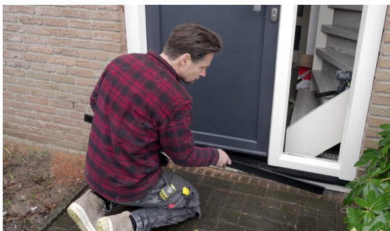
Werk de onderdorpel af met een zwarte kunststof hoekstrip.
