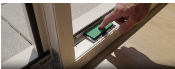
Glasblokjes plaats je op zwarte glasblokzadels, deze zitten al in het kozijn verwerkt en kun je schuiven naar de gewenste positie. Hou voor de plaatsing van de glasblokzadels standaard ca. 10cm uit de hoeken aan.
