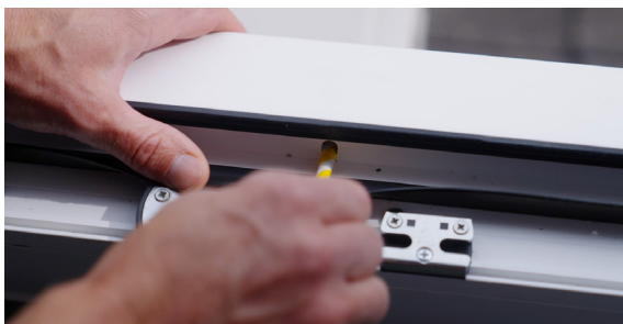
Prik ontwateringsgaatjes eenmaal per jaar door
