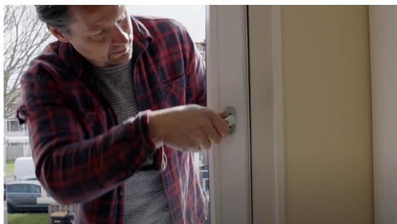
Plaats de grepen en krukken, maar schroef ze nog niet vast
