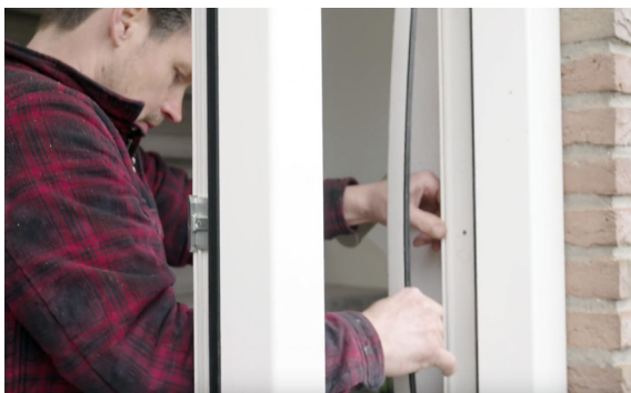
Verwijder de glaslatten in draaidelen
