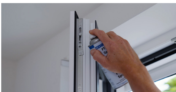
Smeer scharnieren met een teflon spray
